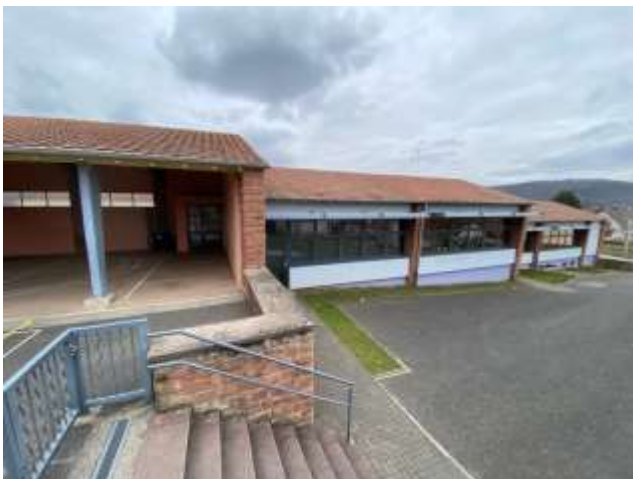
La toiture de l'école d'une surface de 660 m 2 pourra produire 100 KWC
